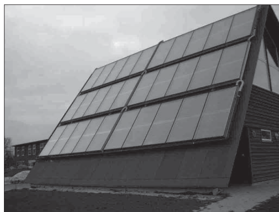
Fælleshus for bogruppe 4, Hjortshøj Andelssamfund ved Århus. Husets store tagflade anvendes til elproducerende solceller.
