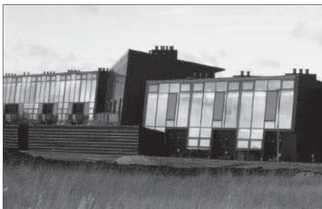
Økohus 99, Skejby ved Århus. Eksempel på hvordan de bæredygtige tiltag indtræder i en ren og æstetisk arkitektur, hvis præmisser er funktionaliteten af byggeriet.
