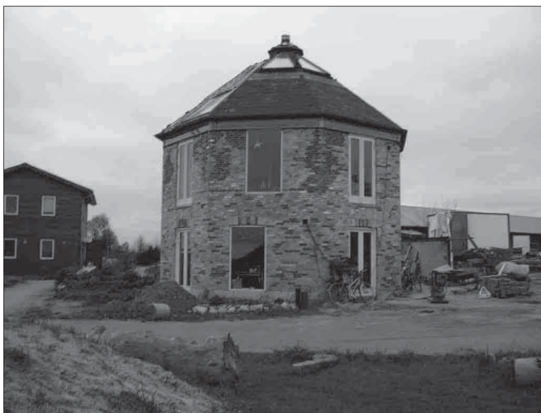
6-kantet hus i bæredygtig bydel i Hjortshøj ved Århus. Eksempel på anvendelse af genbrugsmursten.
