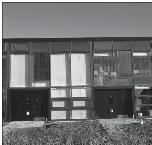
Økohus 99. I glashusets facader er indbygget aktivt solfangeranlæg til opvarmning af brugsvand.
